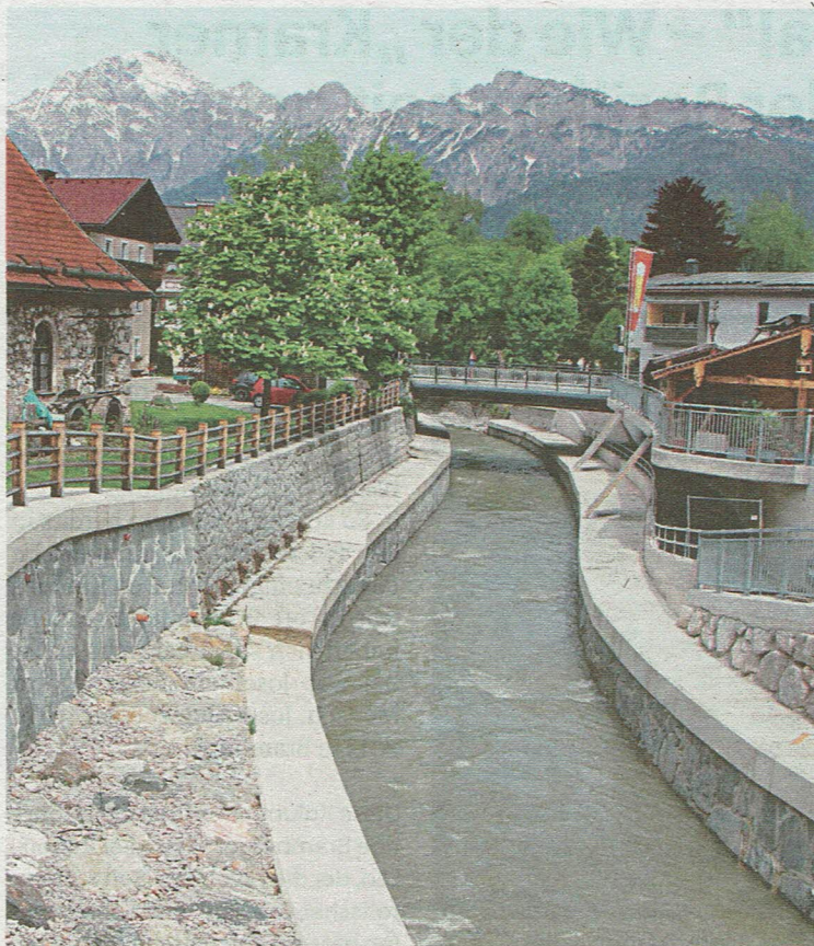
Der Lauf der Urslau wurde im Zentrum von Saalfelden entschärft. Eine Wildbachgenossenschaft gibt es noch nicht. BILD: STADTGEMEINDE/PFEFFER
