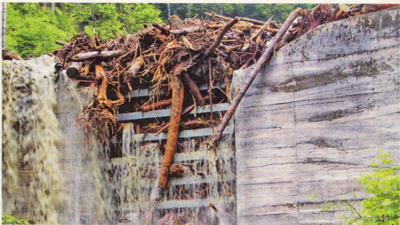
Verkläuserungen bei Wildbächen können zu kata- strophalen Muren und Überflutungen führen. Bild: SN/WLV
