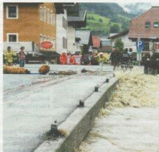
31. Juli 2014: Die 60 Jahre alte Salzachbrücke in Mittersill ist zu niedrig für das Hochwasser. Jetzt kommt eine Hubbrücke. PH: SEBASTIAN KAINDL
